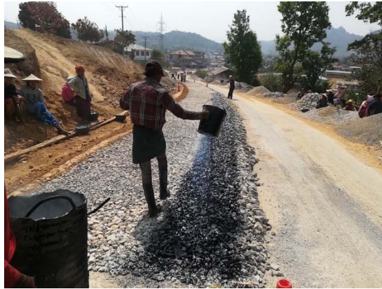
写真 19：手作業でタールを撒いてアスファルト舗装をする様子 (ミャンマー地方道路開発局の施工道路)
