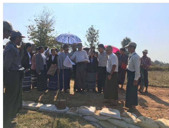
写真 11：施工現場にて専門家と行政職員で 意見交換する様子
