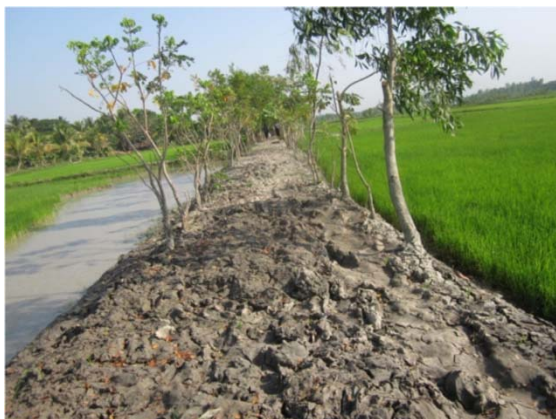
写真 16：施工前の雨季における道路状況
