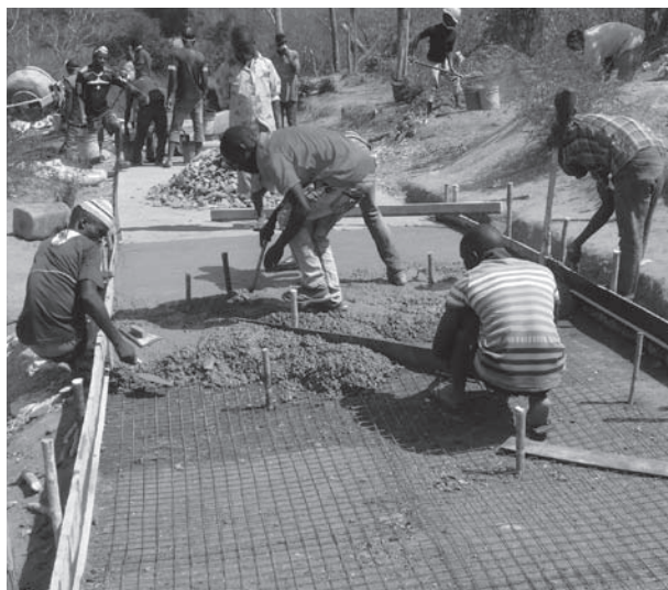
タンザニア南部の村でコンクリート舗装の道路を作る住民
