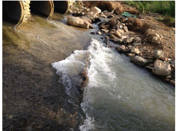
現地調査時_2015 年 9 月_from Camera E
