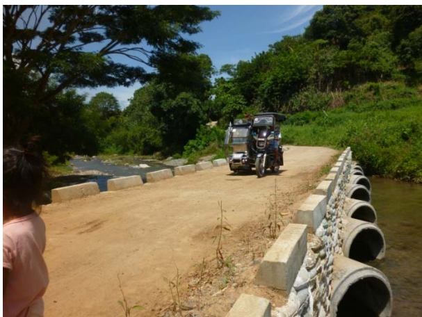
写真 1 施工終了した渡河構造物を通行する車両
