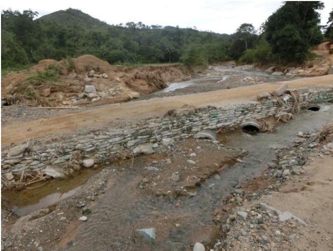
上流部の壁面 目立った損傷はありませんでした。
