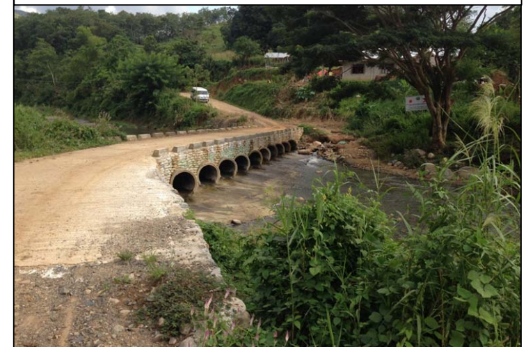
Camera Aからの写真（2015年9月 雨季後）
