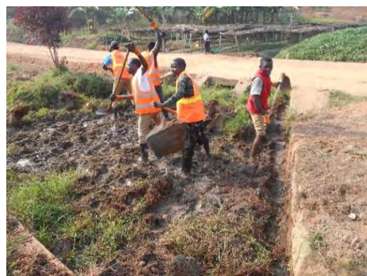
排水口の整備
