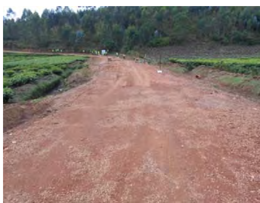
施工後の道路に雨水がたまることのない状態
