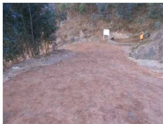
施工後の車両通行が可能な状態
