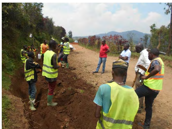
運輸開発庁のクオリティーコントロール 土のう工法についての質問に的確に答える 組合の若者たち
