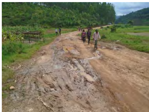
施工前の水がたまりぬかるんでいる状態
