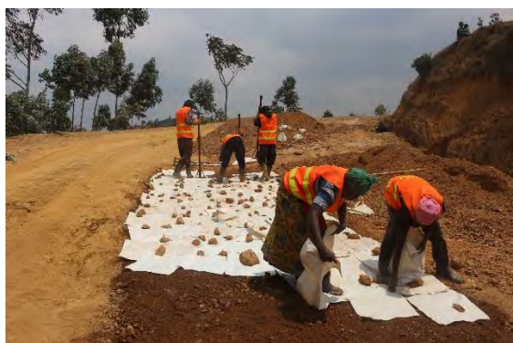
施工中の様子
