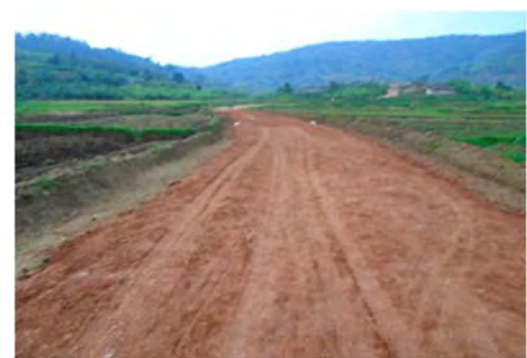
施工後の降雨時でも水がたまらない状態
