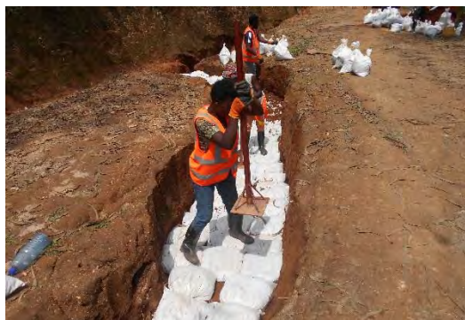
土のう工法で洗堀箇所を補強
