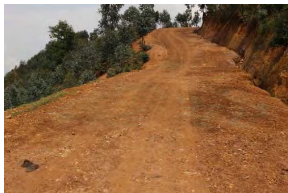
施工後の状態
