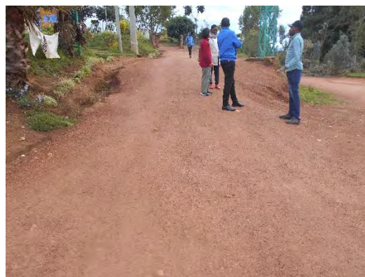
郡庁舎前入り口 雨で洗掘され、車両通行が困難だった庁舎入り口から庁舎内駐車場まで道路の整備を受注し、土のう工法で整備
