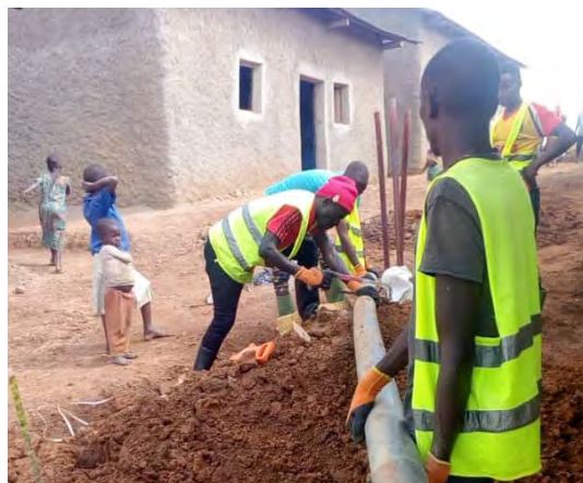
道直し訓練で得た道路側溝施工の技術を生かし、居住区域を豪雨から守る排水溝を施行。災害対策としても活かされる CORE 道直しの技術。
