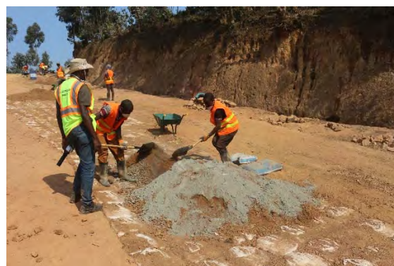
洗堀を防ぐために表層土にセメントを混入
