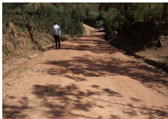
施工後の車両通行が可能な状態
