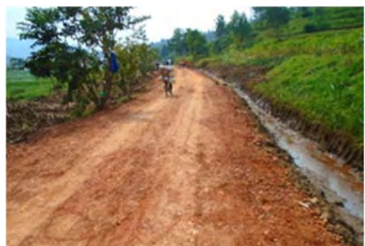
施工後の橋も新たに設置しぬかるみもない状態
