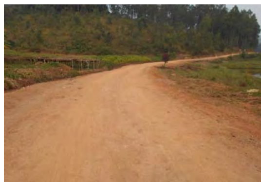
施工後の雨季でもぬかるみのない状態
