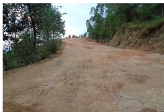
施工後 洗堀箇所を補強し通年通行可能な状態
