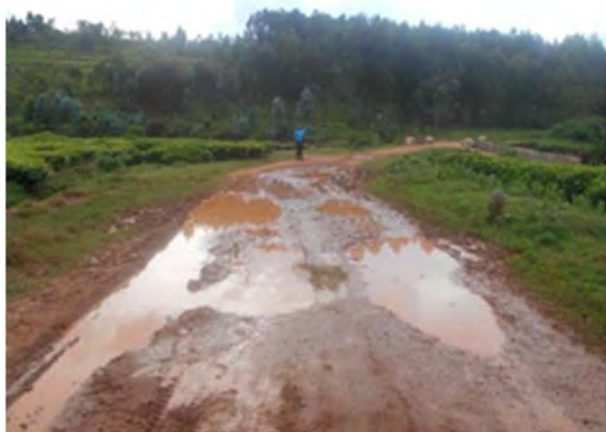
施工前のぬかるみがひどい状態
