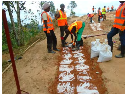
土のう工法で洗堀箇所を補強
