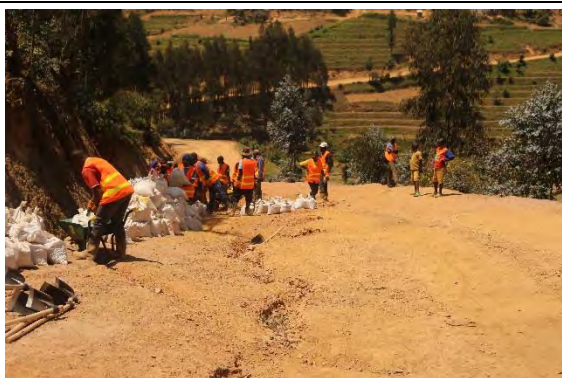
洗堀箇所を土のうで補強
