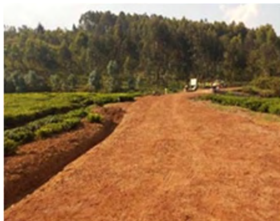
施工後の降雨後でも水たまりのない状態
