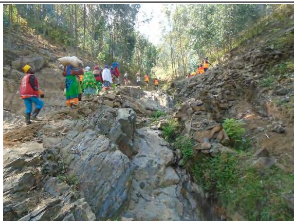
施工前 車両での通行は不可能な個所
