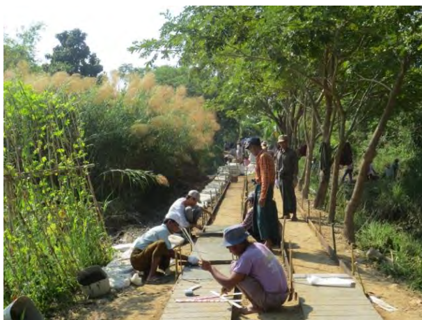
③ 施工現場 コンクリート施工
