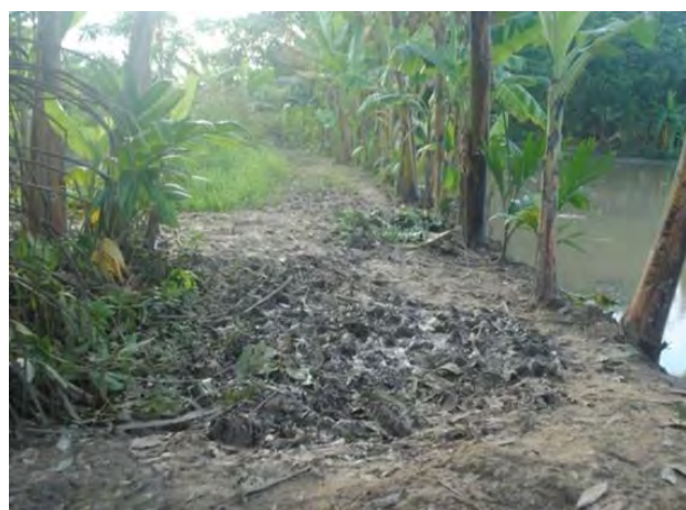
⑧ 施工前の様子（雨季時）
