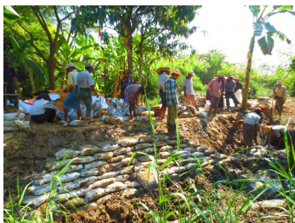
④ 住民研修 土のうに中詰めする土は現地の粘土を利用
