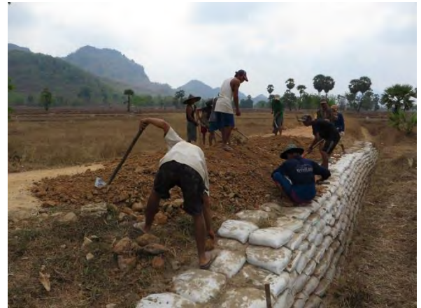
② 施工風景
