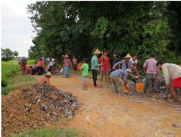
① 施工風景
