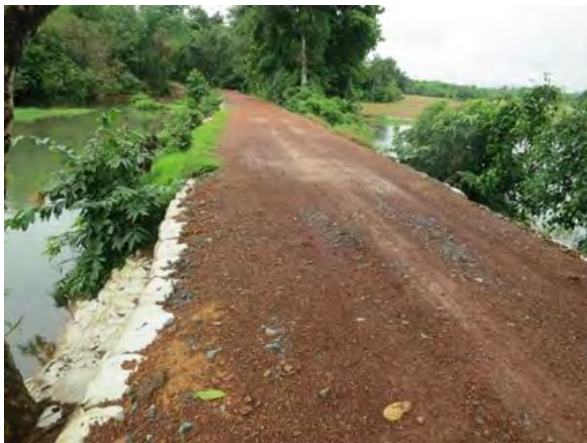
⑨ 雨季時・施工対象道路と周辺の様子。 道路周辺は冠水しているが、嵩上げ工事により、雨季時の通行も可能となっている。
