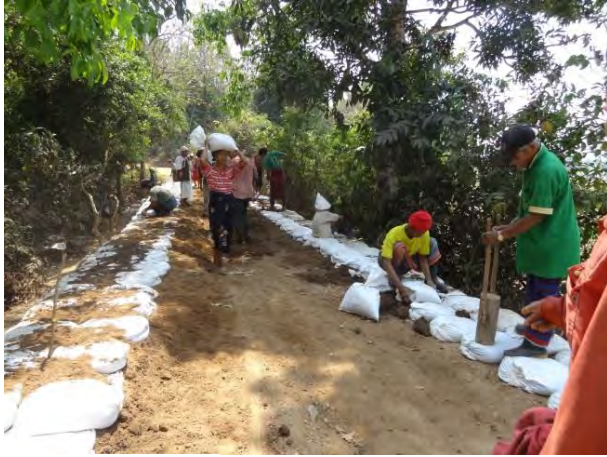
③ 施工現場
