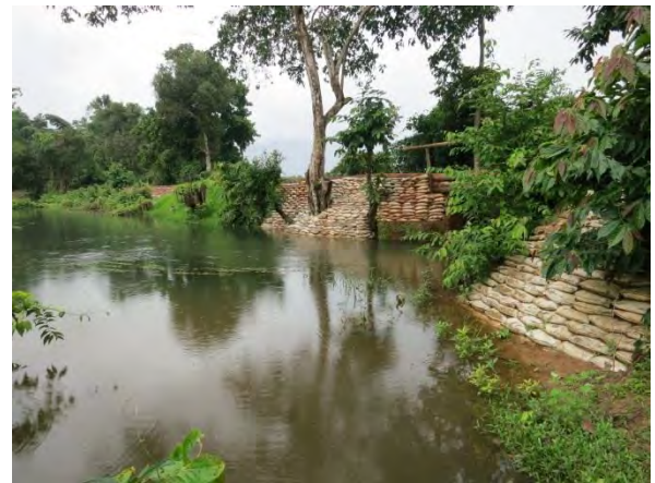
⑩ 雨季時・施工対象道路と周辺の様子。
