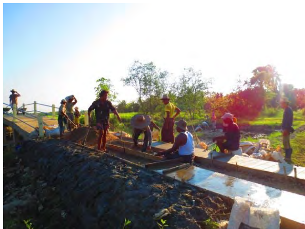
⑤ 現在では住民のみでコンクリート施工含め 道路改築工事が可能となった
