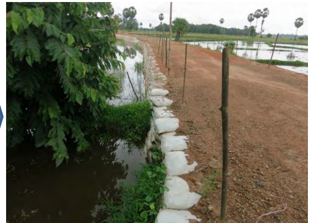
④ 施工道路周辺は冠水しているが嵩上げ工事により、雨季時の通行も可能となった。
