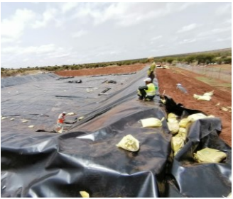
シートの設置
