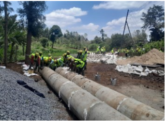
カルバートの設置
