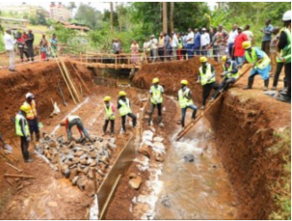
ボックスカルバートの設置部
