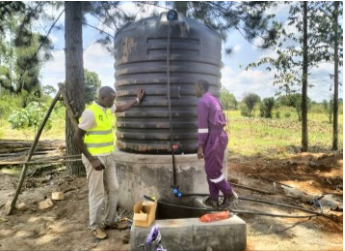
育苗場における給水タンクの設置
