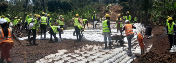
土のうによる沼地補修
