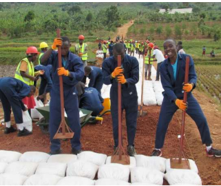
国立高等技術学校土木科道路整備コースに新たに設けられた、土のう実技研修に協力
