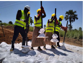
土のう工法を用いた農道補修訓練
