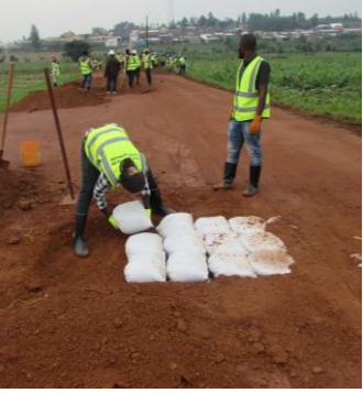
雨季後の点検整備研修
