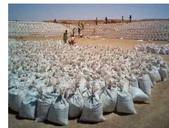
ため池の堤体に用いる土のう
