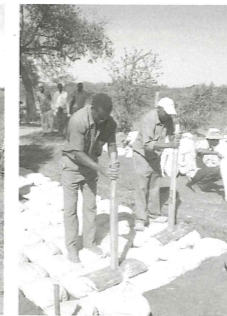
農民自らが行う「土のう」による道なおし
