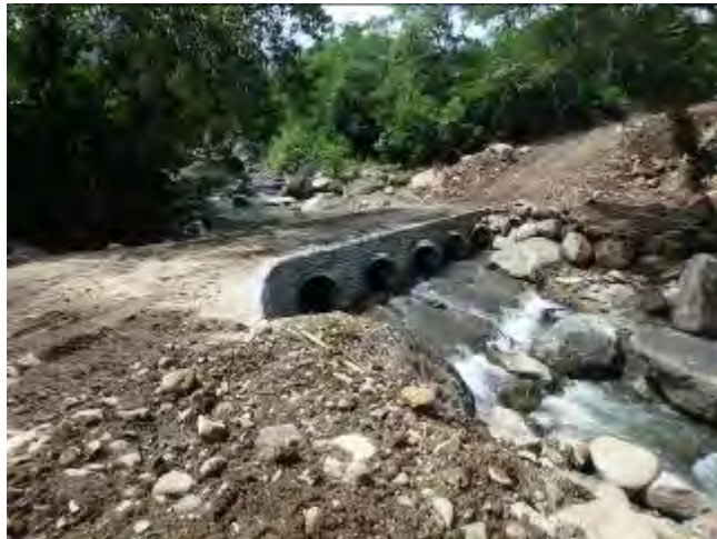
他 NPO の要請に応え、技術指導し建設した渡河部対策工（フィリピン）
