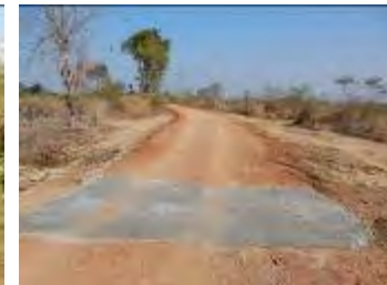
施工後の道路
