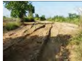
施工前の道路
