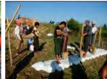
専門家による土のう工法研修
