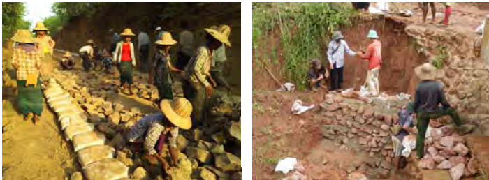
碎石敷き並べの様子 土のうと石積による斜面補強
