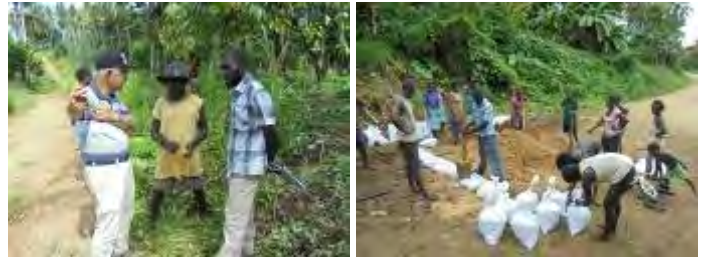
吉田シニア専門家による指導 路面沈下部に土のうを敷設する様子
