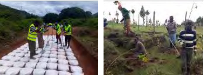
マクエニの現場での締固め作業 地域住民による植林活動
