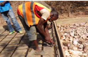
坂部コンクリート舗装での鉄筋組
