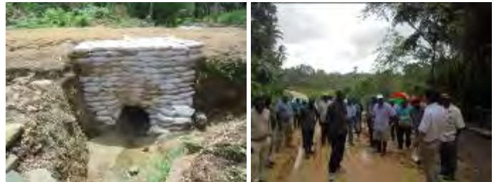
既設パイプ端部を土のうで補強 事業成果発表ワークショップで現地視察
