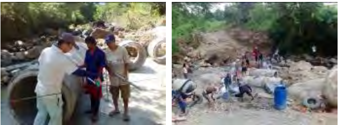
パイプ設置位置確認状況 パイプ間中詰材バケツリレー
