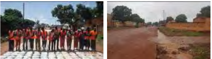
土のう締固めの様子 整備後の雨季の様子
