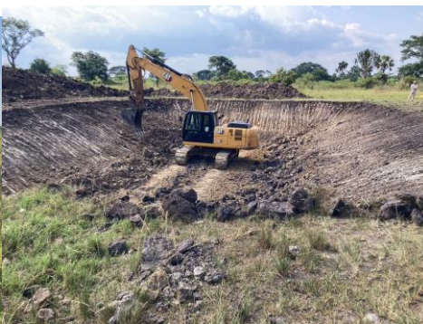
画像 3 掘削の様子
