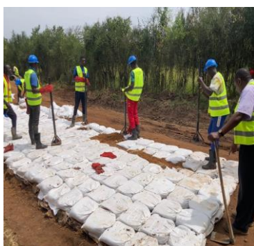
画像 4 土嚢を並べる様子
