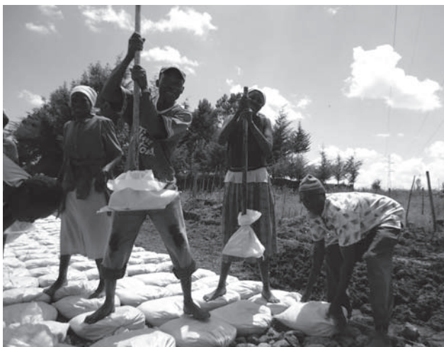
住民自身が土のうを用いて道路を整備する（ケニア）
